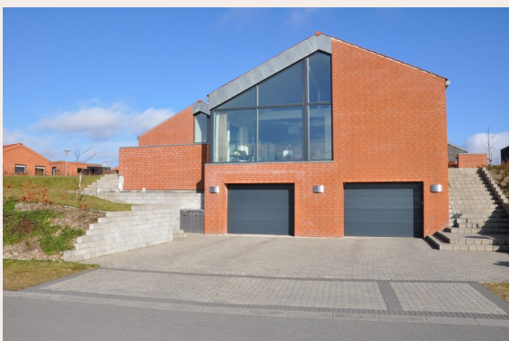
Illustrerende foto til §5 stk.3 og 4 : Eksempel på bolig der er 1 etage på grundens højeste del og 2 etager mod grundens laveste del.
